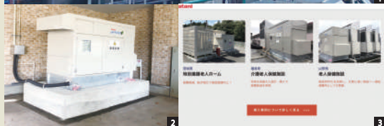
[1] 輸入から配送まで一貫した供給体制でお客さまへLPガスをお届けするための中継基地 [2] 災害時に強いLPガスエンジンを搭載したLPガス非常用発電機 [3] 「導入実例」のページでは具体的な効果や設備を見ることができます
