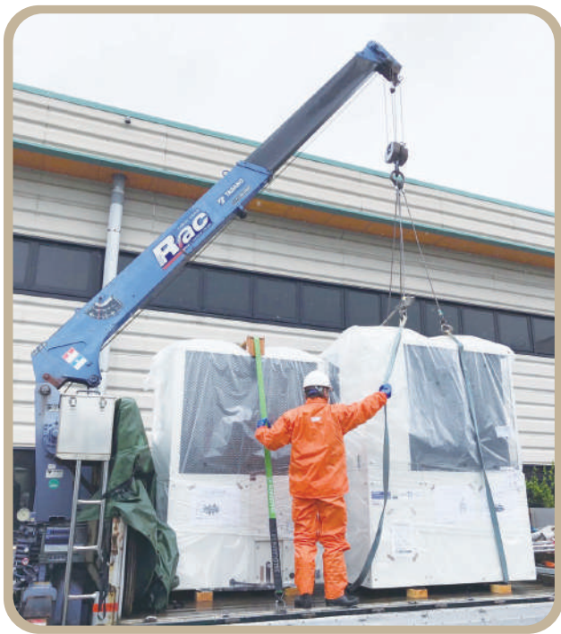
▲ 高品質なエネルギーをいつでも安定してお届けするため、丁寧に作業しています
