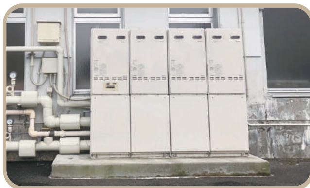
▲ 実際にお客さまへ導入している50号ガス式マルチ給湯器は複数連結も可能です
